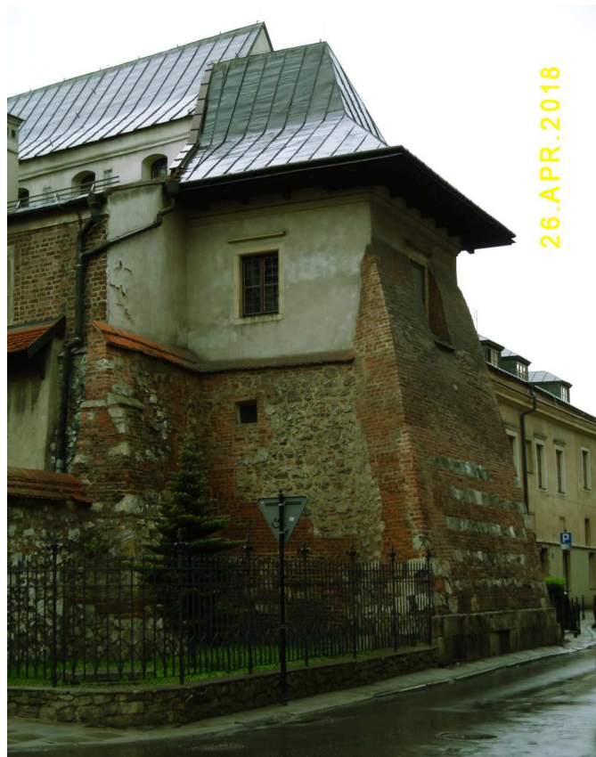
Fot. nr 62 (62-68). Wzdłuż ulicy Paulińskiej i fragmentów murów obronnych dawnego Kazimierza. Tu baszta obronna w narożu z ulicą Augustiańską.
