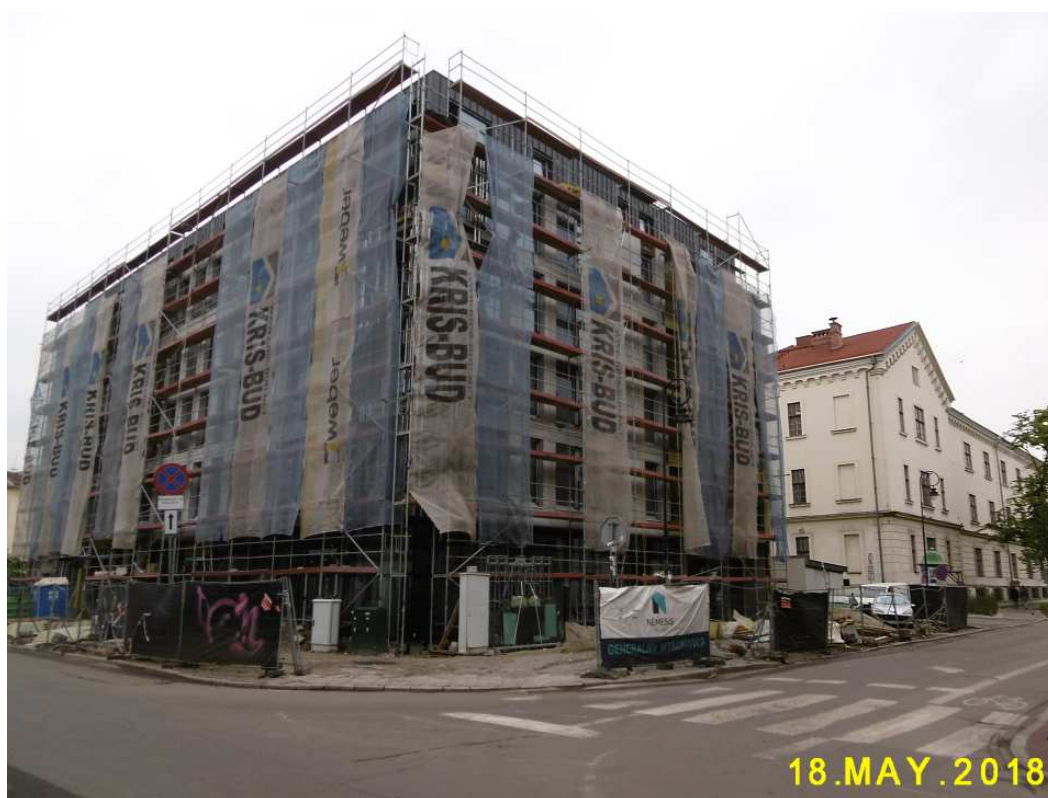
Fot. nr 117. Końcowy etap budowy giganta na styku ulic: Dolnych Młynów i Rajskiej.
