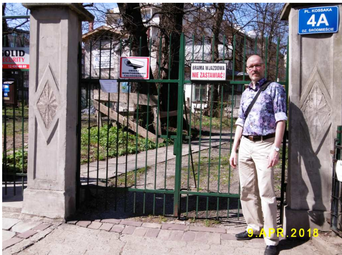
Fot. nr 133. Tapani Karkkainen, mój znajomy z FB, tłumacz literatury polskiej, przed remontowanym dworkiem Kossaków. Remont się dłuży, ale posuwa się do przodu.
