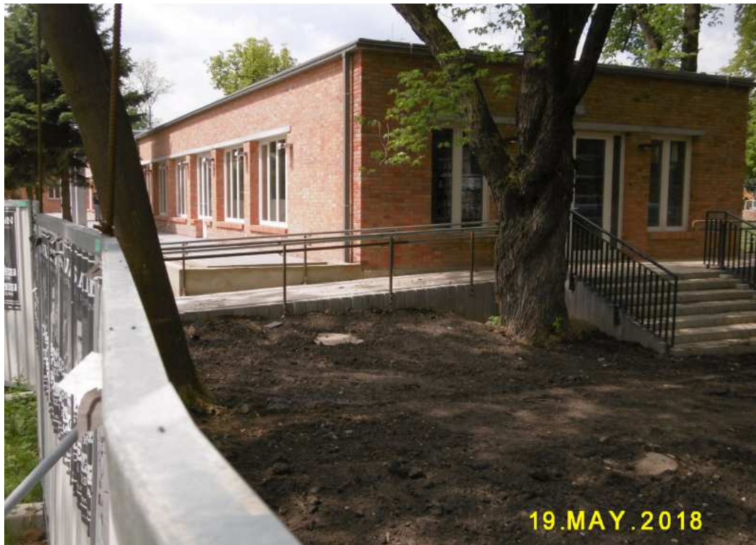
Fot. nr 140. Na plus tej inwestycji trzeba zapisać rekonstrukcję budynku dawnych szatni.
