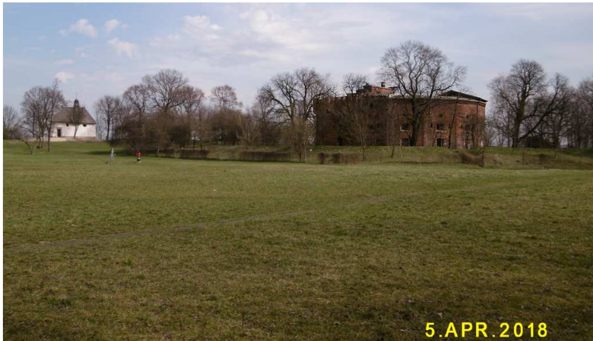
Fot. nr 185 (185-187). Kilka ujęć fortu nr 31 („św. Benedykt”); tu widok z błonia przed fortem.
