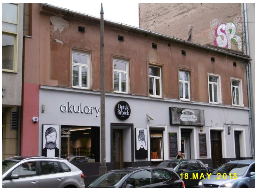
Fot. nr 123. Jednopiętrowy dom z ulicy Czarnowiejskiej 7, który nadal trwa.
