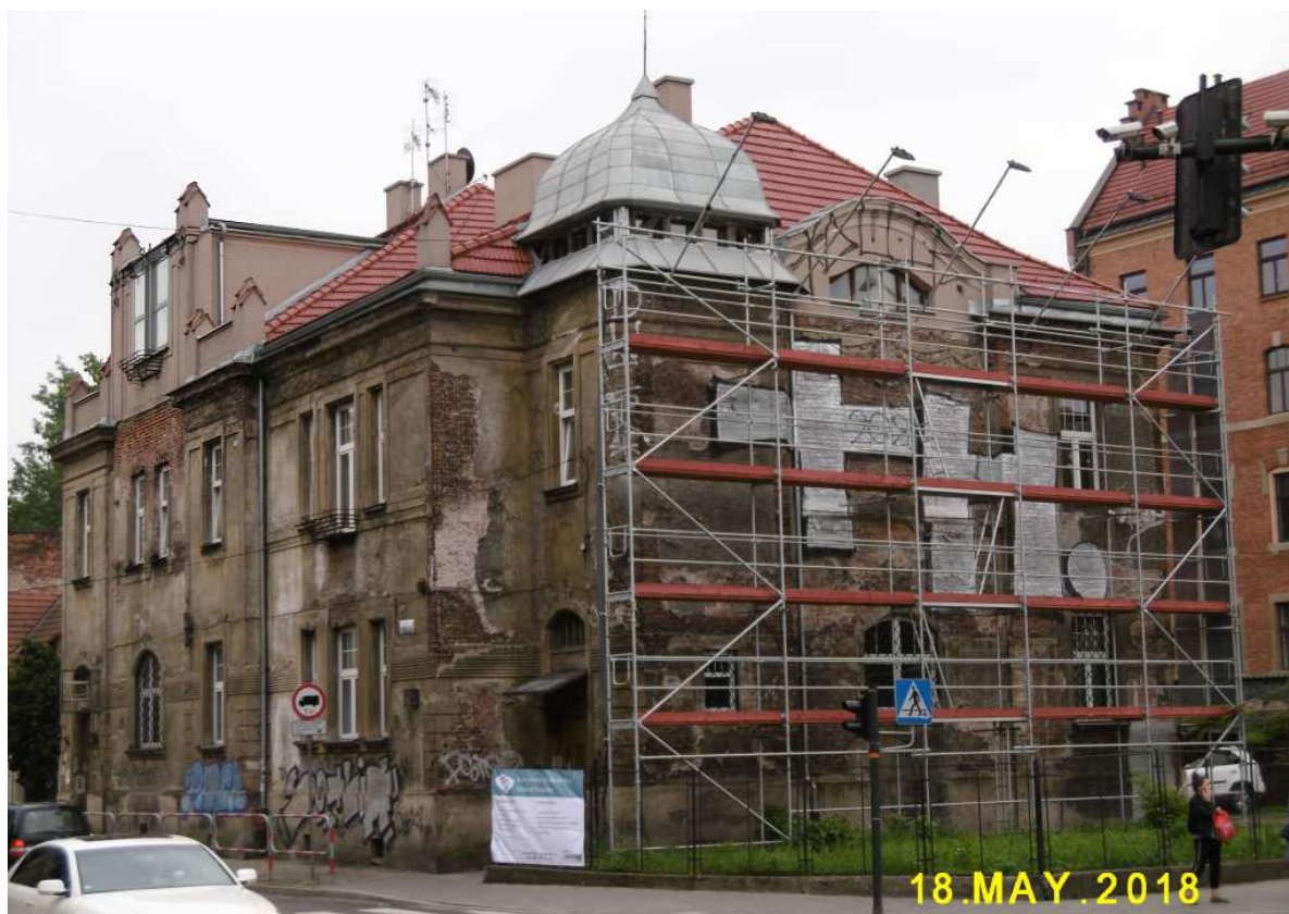
Fot. nr 126. Secesyjna willa spod nr 8 w początkowym etapie remontu.
