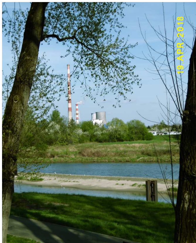
Fot. nr 272 (272-273). Kominy elektrociepłowni w Łęgu.
