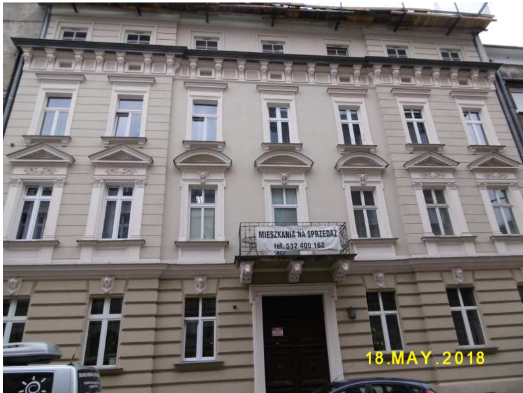
Fot. nr 114. Nadbudowana o piętro, pod pretekstem naprawy dachu, kamienica pod nr 11.
