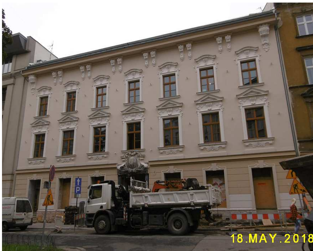
Fot. nr 44. Odnowiona po pożarze dyskoteki kamienica pod nr 15.
