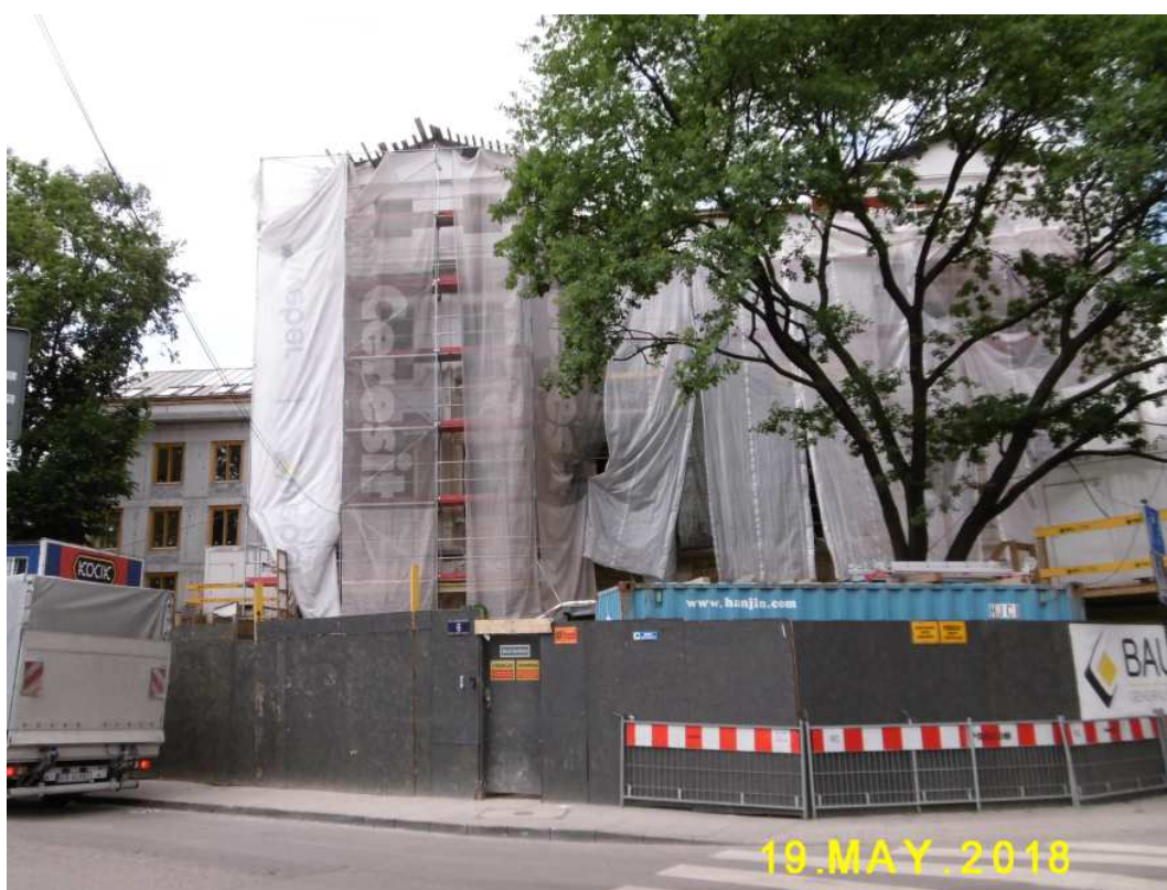
Fot. nr 131. Widok z placu Kossaka.
