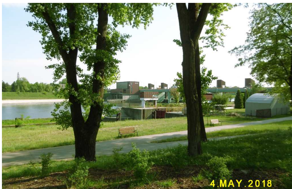
Fot. nr 277 (277-281). Kilka ujęć stopnia wodnego na Dąbiu. To ujęcie od strony ulicy Widok.
