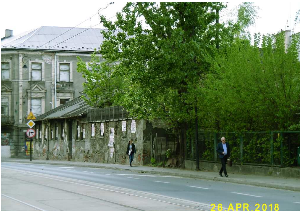
Fot. nr 177. Widok od strony ulicy Wielickiej.
