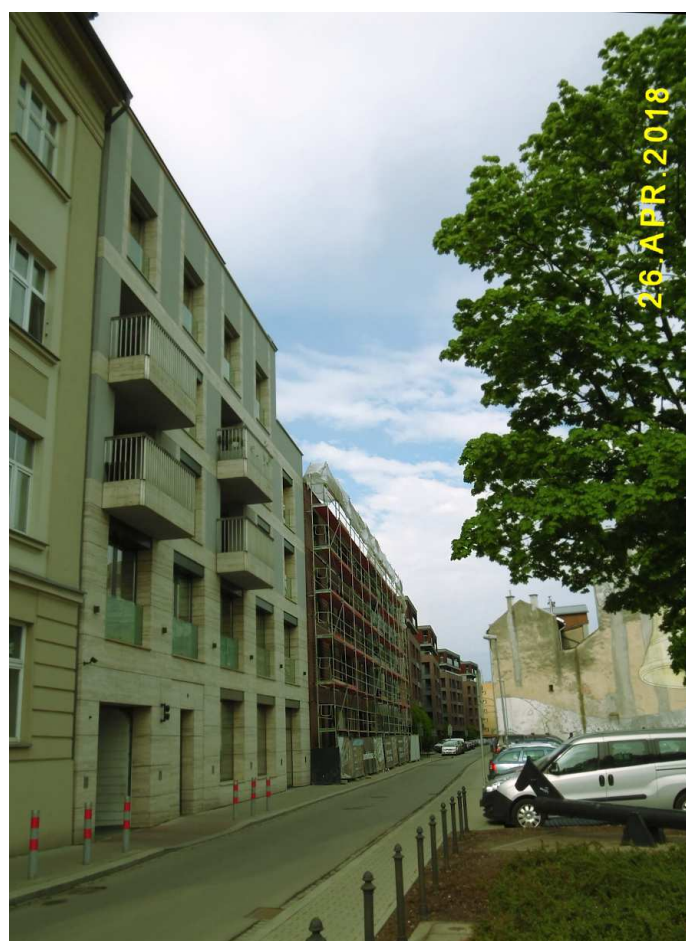
Fot. nr 157. Nowa zabudowa ulicy Piwnej w ujęciu z ulicy Józefińskiej.
