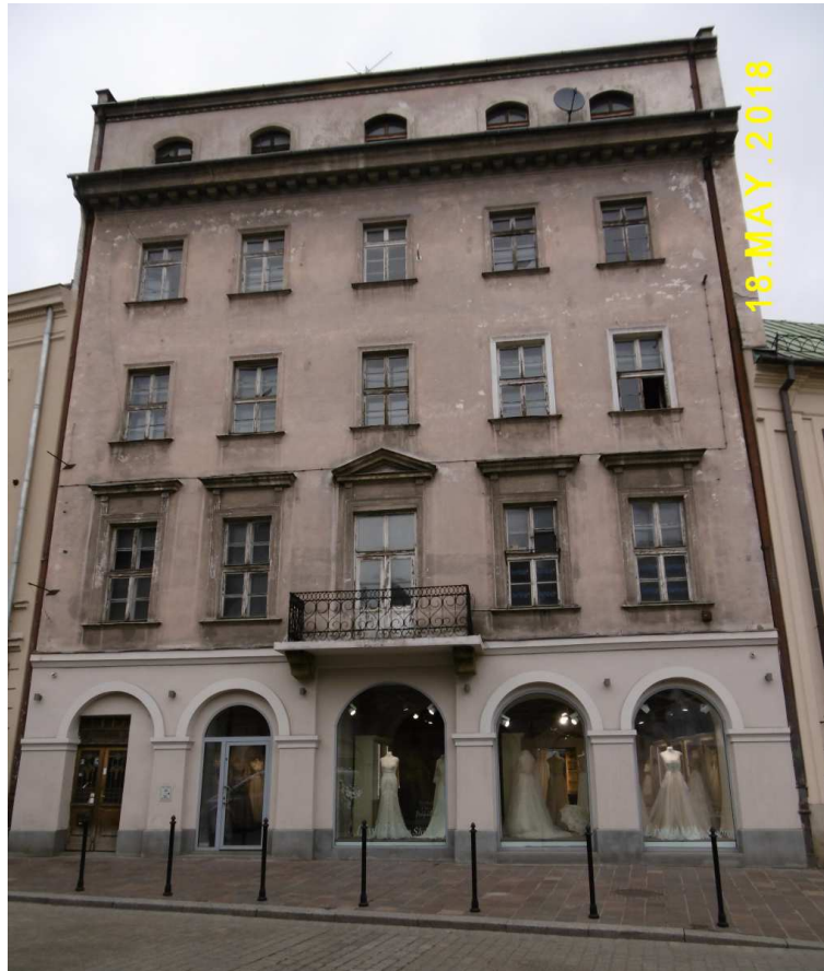
Fot. nr 36. Kamienica pod nr 14 przed remontem.
