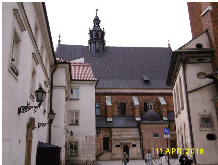
Fot. nr 28. Widok od strony ulicy Szpitalnej na kościół św. Barbary.
