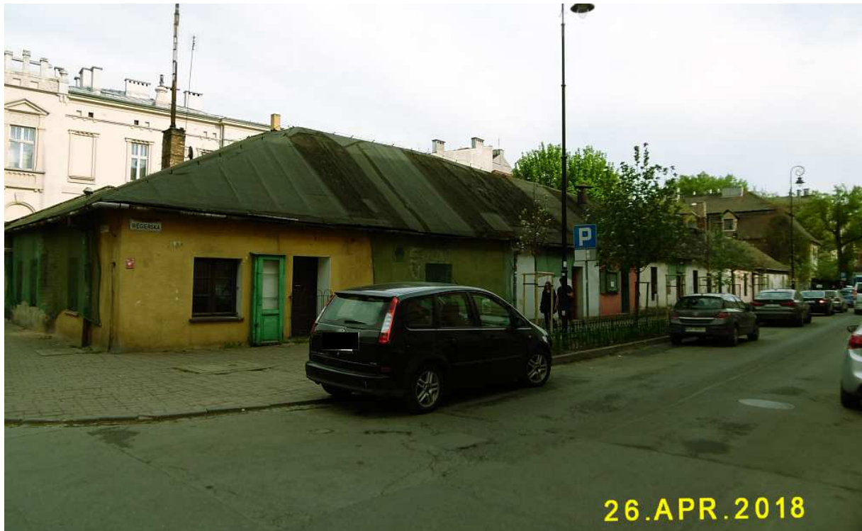
Fot. nr 158. Parterowa zabudowa wzdłuż ulicy Węgierskiej 13-15, której budynek jest mocno zagrożony. Widok z ulicy Józefińskiej.
