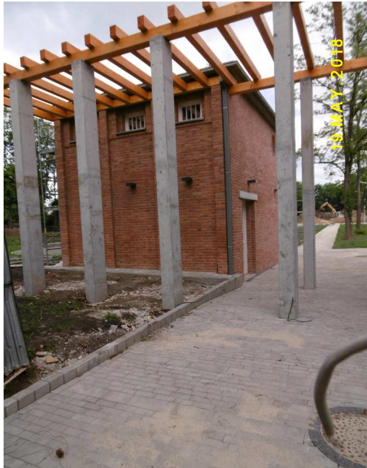
Fot. nr 142 (142-143). Budynek użytkowy przy dawnym basenie głębokim. Co powstanie na jego tyłach w miejscu basenu?
