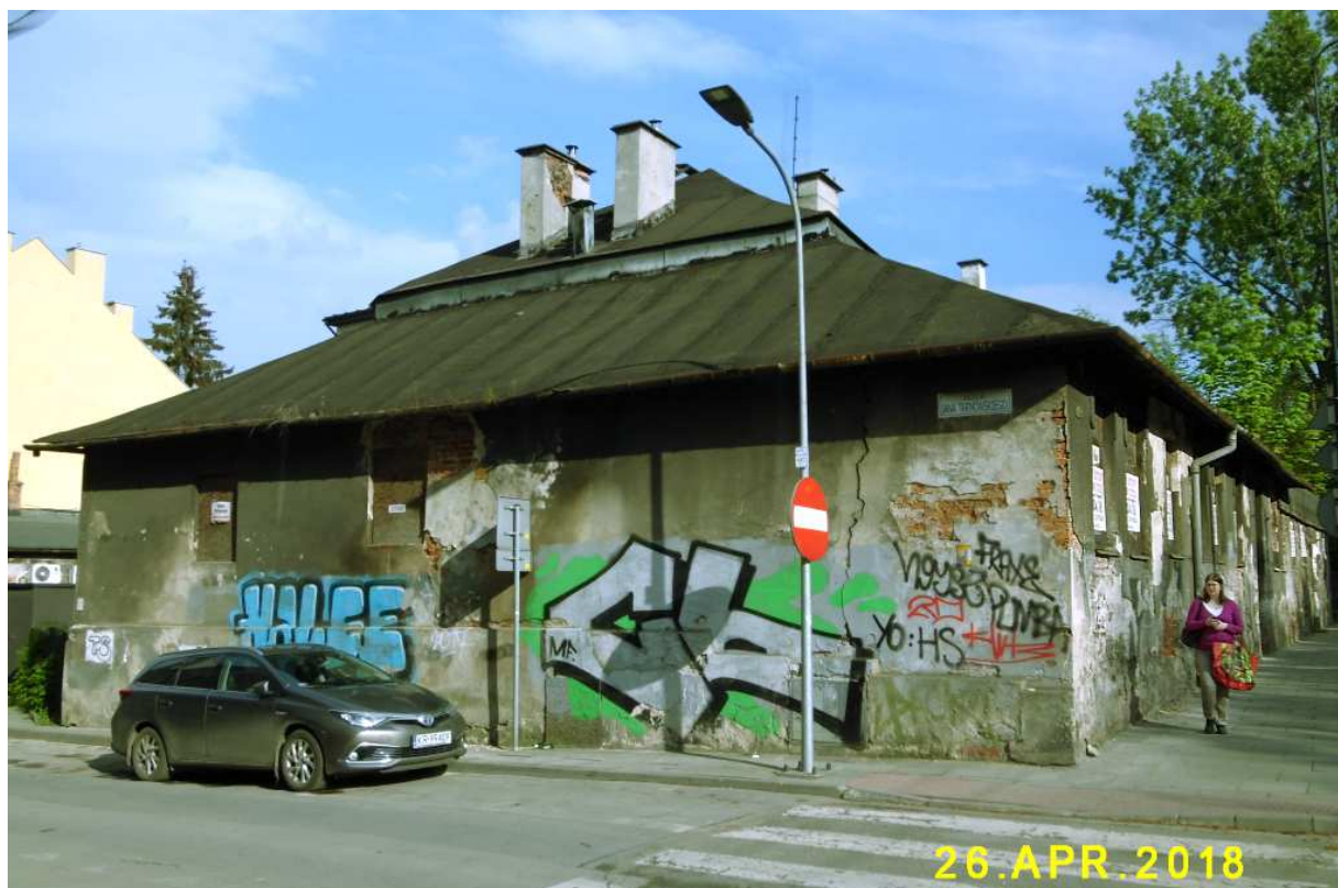
Fot. nr 174 (174-177). Ruina dworku z ulicy Limanowskiego 47, który powstał pod koniec XVIII wieku. Niestety po dziwnym pożarze obiekt został skreślony z rejestru zabytków, ale ostatnio znów został tam przywrócony, więc jest szansa na jego restaurację.
