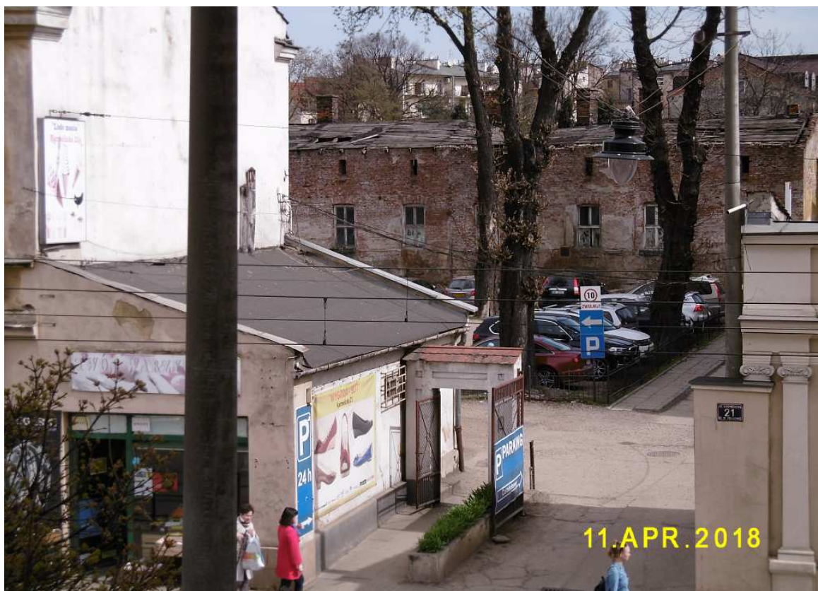
Fot. nr 100. Podwórko przy zabudowaniach klasztoru Karmelitów na tyłach budynków o numerach: 21-25.
