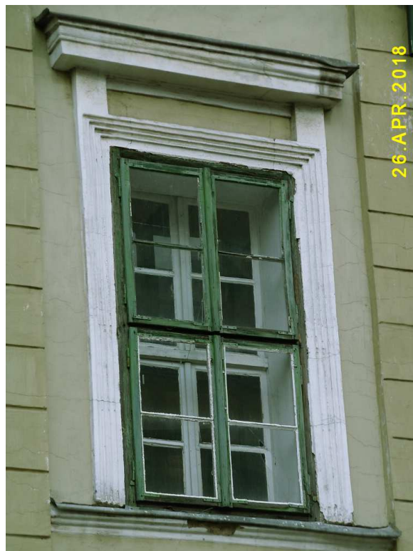
Fot. nr 84. Jedyne zachowane do dziś oryginalne okno.
