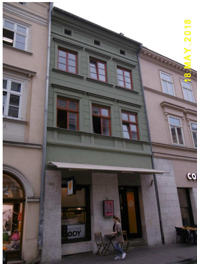
Fot. nr 9. Odnowiona fasada kamienicy z ulicy Szewskiej 6.
