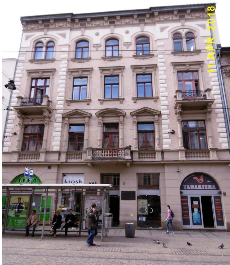
Fot. nr 92 (92-93). Kamienica przy ulicy Karmelickiej 4
