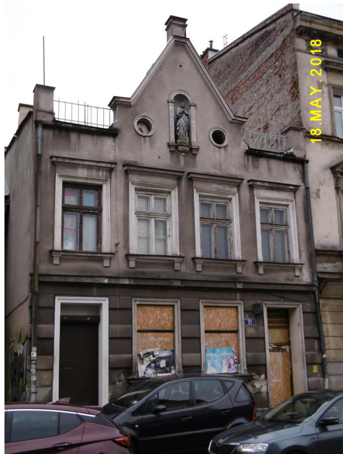
Fot. nr 125. Jak będzie wyglądał ten budynek spod nr 21 po remoncie?
