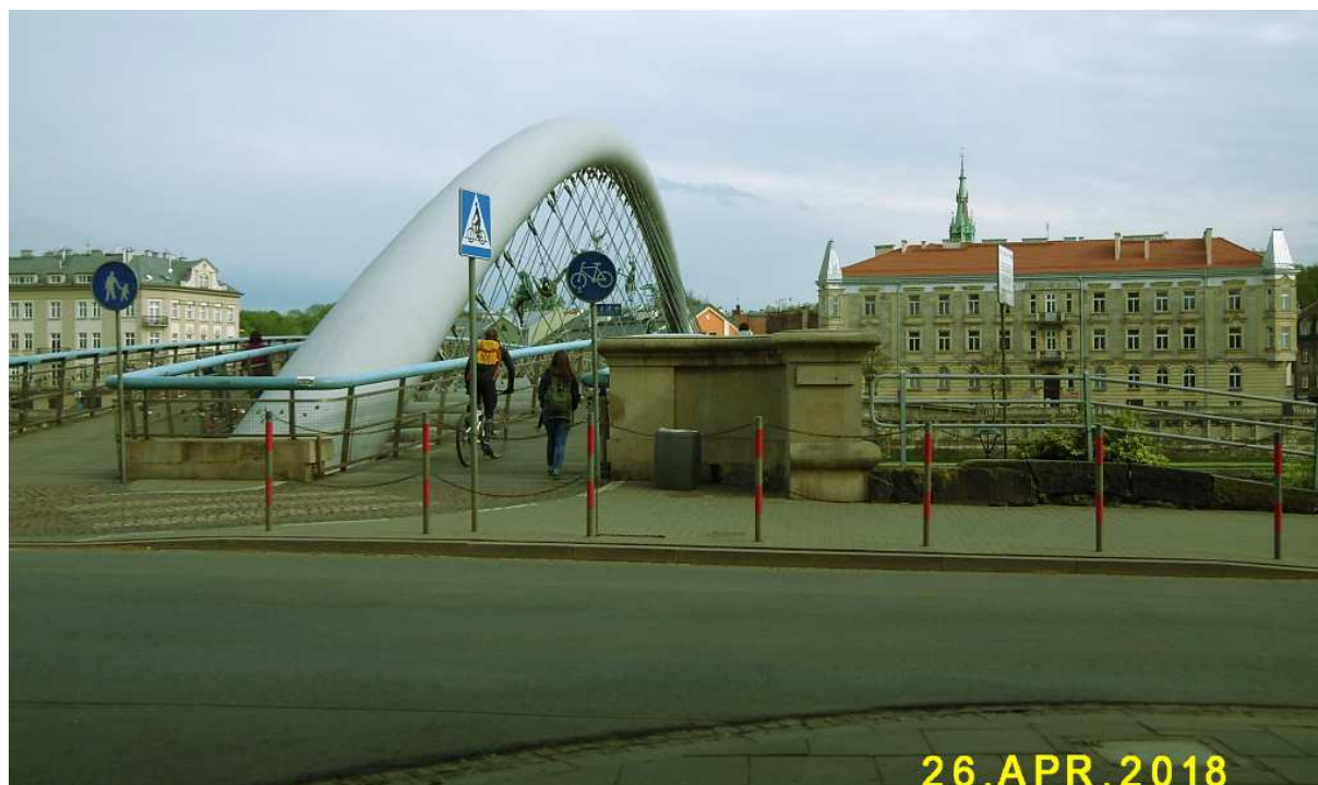
Fot. nr 150 (150-152). Widoki Podgórza w ujęciach z kładki o. Bernatka, która powstała na przyczółkach starego mostu podgórskiego im. Franciszka Józefa.
