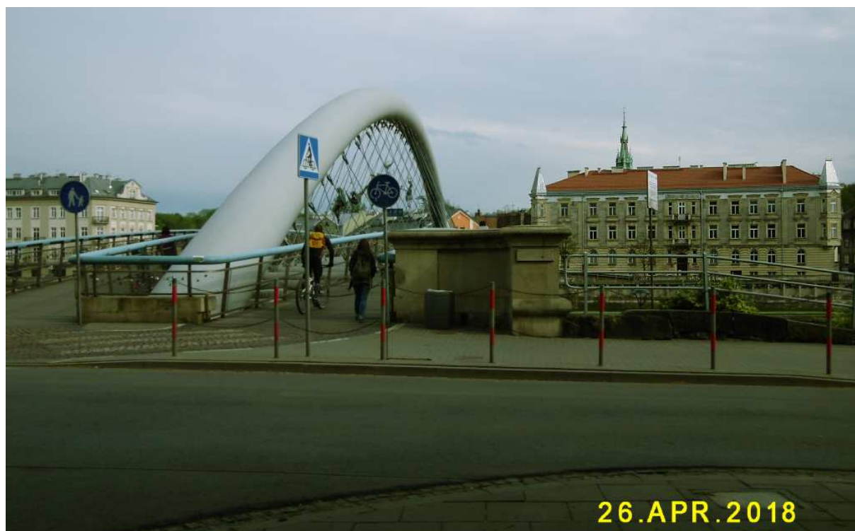
Fot. nr 91. Ponad kładką o. Bernatka w stronę Podgórze.
