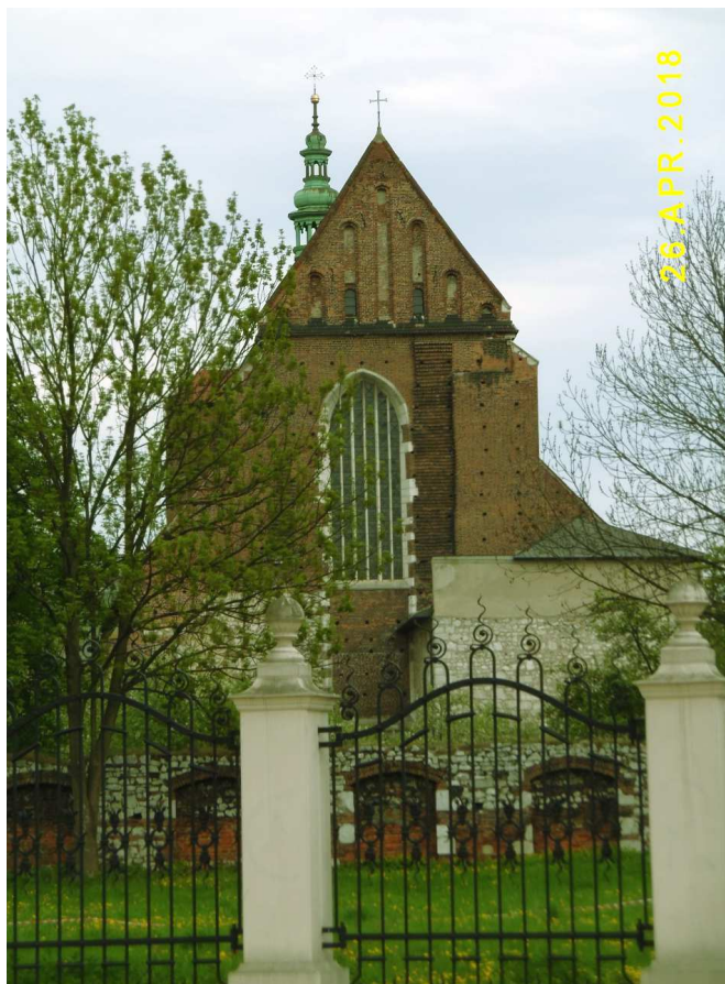
Fot. nr 78 (78-79). Zachodnia ściana szczytowa kościoła św. Katarzyny
