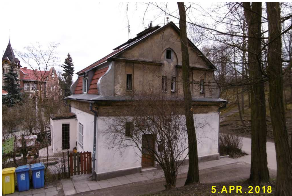
Fot. nr 204 (204-207). Tyły domów z ulicy Parkowej w ujęciach z Parku Bednarskiego. Tu domek nr 10, zapewne kiedyś służbowy, przy wejściu z ulicy (powstał ok. 1910 roku).
