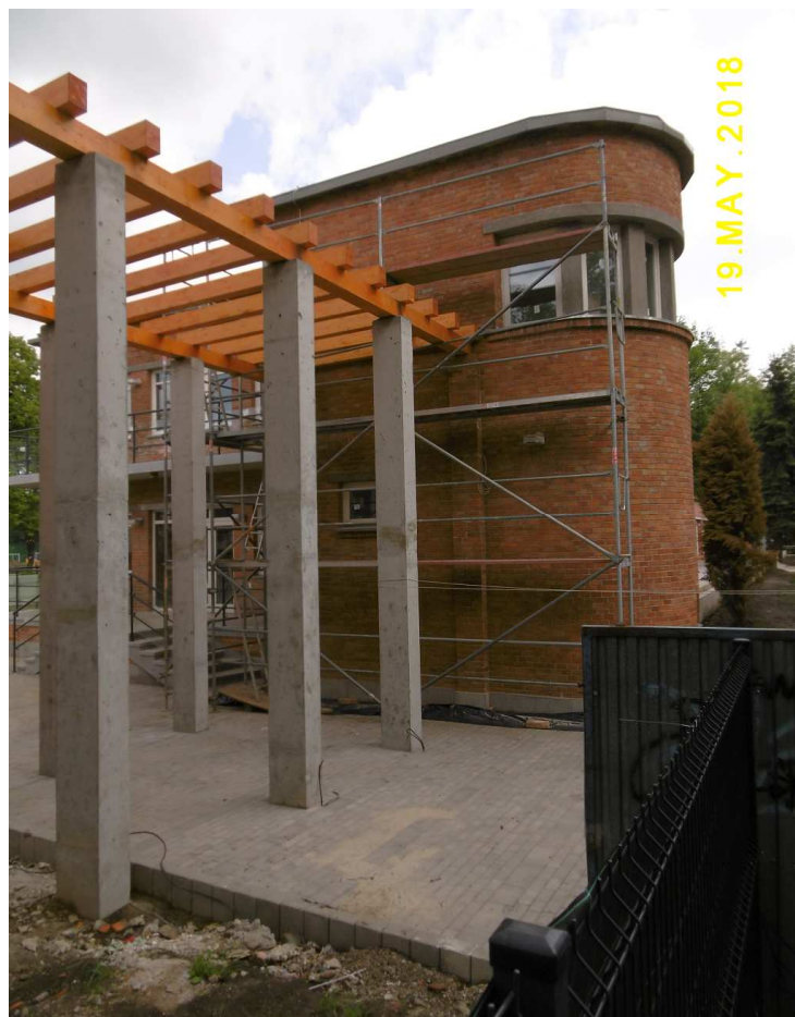
Fot. nr 141. Odnowiona część mieszkalna przy dawnym basenie głębokim (460/220 cm).
