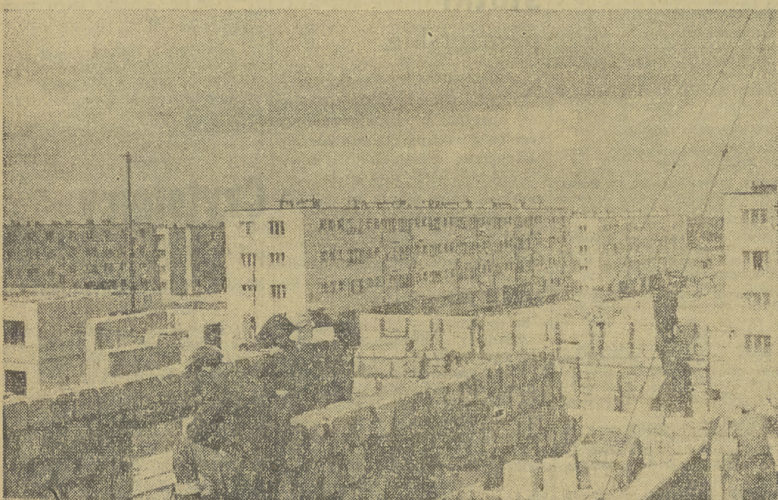
BUDOWA osiedla mieszkaniowego „Kolo” w Warszawie postępuje szybko naprzód. Na zdjęciu Brygada Mieczysława Szymańskiego zatrudniona przy budowie bloku VIII wyrabia przeciętnie 180 proc. normy. (CAF — fot. Nowosielski)
