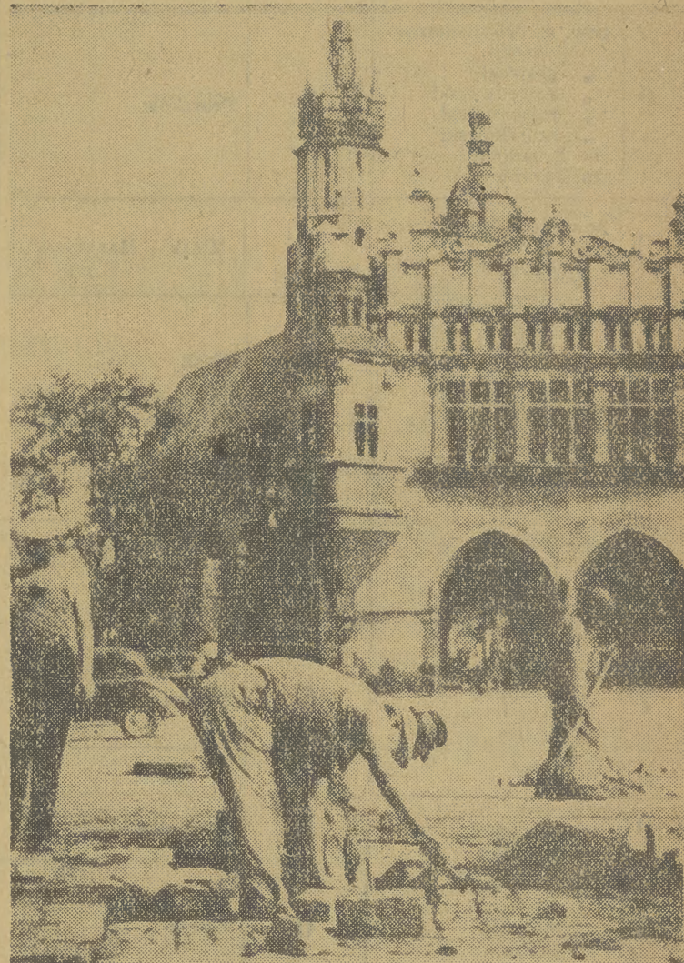
Na Krakowskim Rynku przystąpiono do wstępnych prac przy usuwaniu torów tramwajowych. Pierwsi przystąpili do robót brukarze, którzy wykonali prace przy rozbiórce nawierzchni.
