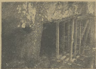
Fragment pierwszej części korytarzy podziemnych pod pałacem Montelupich zabezpieczonych stemplami
