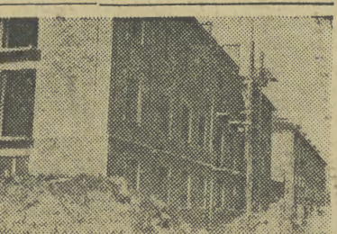
Budowa osiedla mieszkaniowego dla robotników Kombinatu-Skórzanego w Nowym Targu.
