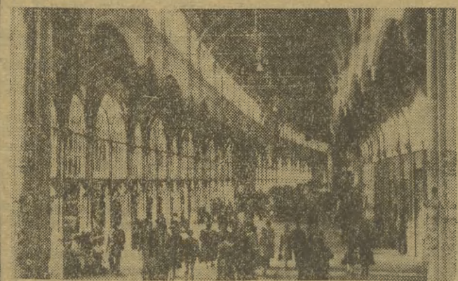
3) Kryta 120-metrowej długości kolumnada jest miejscem spotkań wszystkich kuracjuszy.
