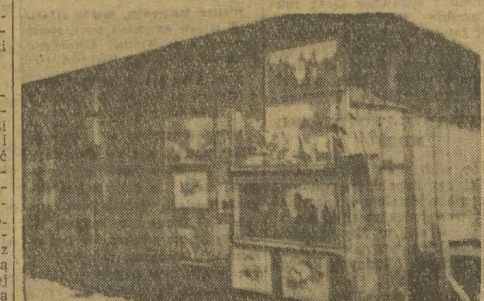
„Salon“ malarski na ścianie drewnianego baraku.
