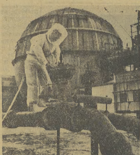
Pracownik w ubraniu ochronnym kontroluje zawory znajdujące się na zewnątrz reaktora kulistego.
