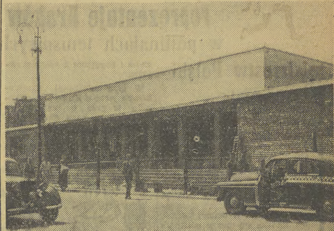
Trwają prace przy budowie nowego dworca autobusowego w Krakowie. Fot. W. Pawłowski
