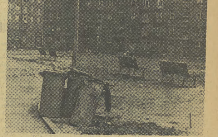
Jakich „obrazków” można spotkać w Nowej Hucie bardzo wiele. Choć domy dawno zamieszkałe — teren między blokami nie uporządkowany. Przykrego wrażenia nie zdołają zatrzeć ustawione wśród resztek materiałów budowlanych ławki. „Malownicza” grupka pojemników — też na razie nie spełniających swego przeznaczenia, uzupełnia krajobraz. Fot. J. Lewicki
