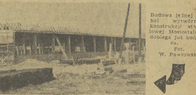
Przypomina to nieco ogrodnicze cieplarnie — a jest konstrukcją dachową, montowaną na ziemi dla jednej z hal stałej siedziby nowohuckiego Mostostalu.
