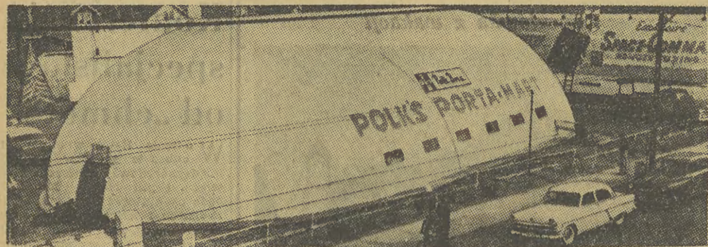
Oto jeszcze jedno zastosowanie tworzywa sztucznego w USA. Budynek z nylonu powleczonego winylem, który napompowuje się jak balon, służy za przenośny magazyn. Urządzenie nadmucha się przy pomocy pompy powietrznej. Całość ściśle przylega do ziemi dzięki przyciskającej podstawie nylonowej rurze, wypełnionej piaskiem lub wodą. Napompowanie budynku trwa godzinę. Waży on 150 kg, korzystać można z niego przez 6 lat.
