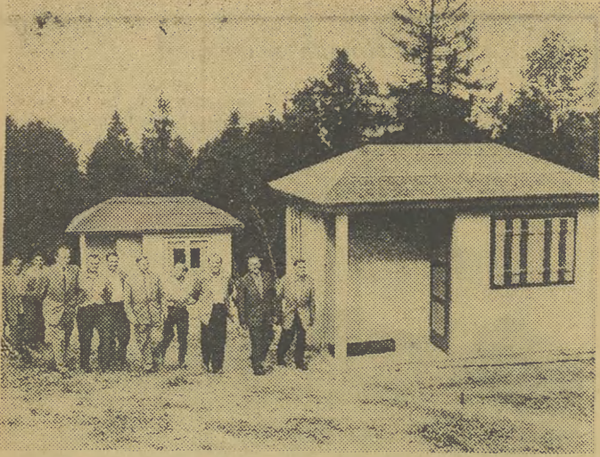
20 pracowników Krakowskich Zakładów Sieci Elektrycznej w swoisty sposób spędzają swój tegoroczny urlop wypoczynkowy. Od świtu do nocy z... łopata w ręku, kielnia, piła, malowało, tynkowało, budowało. I tak w Wysokiej koło Jordanowa powstało miasteczko campingowe. 20 zapaleniów stało się posiadaczami własnych kolorowych domków.
